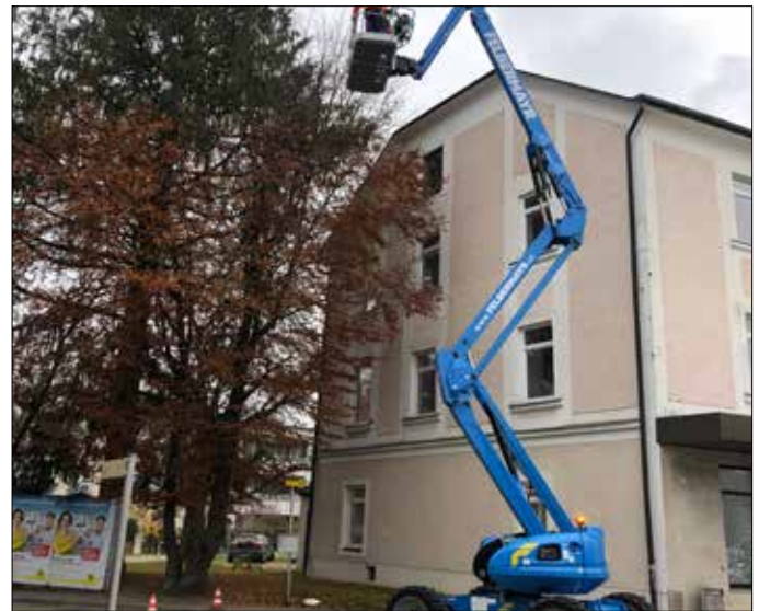
Der Einbau der neuen LED-Lampen bringen unsere Stadt.
